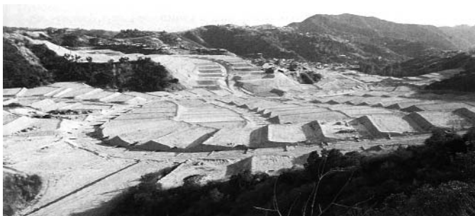
Очистка земли для особняков в Лос-Анджелесе
