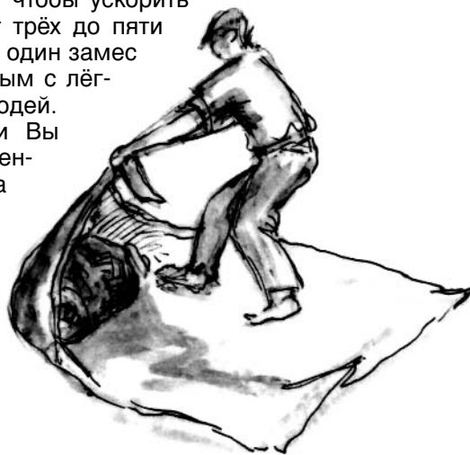
Соло смешивание с использованием брезента.
