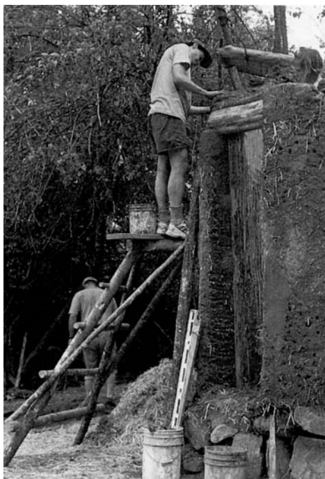
Самодельные козлы из брёвен высотой 1,5 метра
