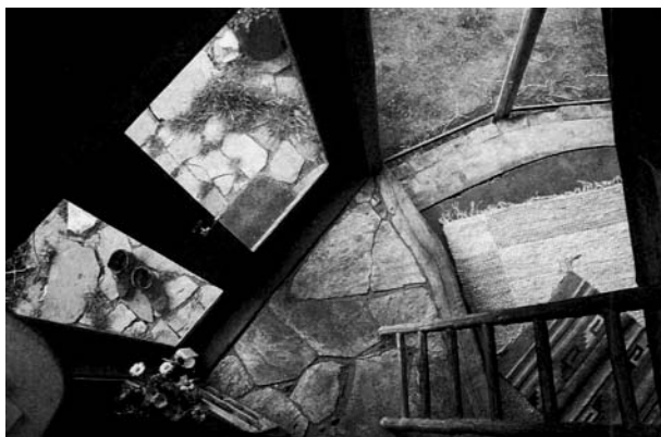
Пол из каменных плит создаёт непрерывный переход из кухни в патио. Справа деревянная ступенька, отделяющая земляной пол. Дизайн и изготовление Коб Коттедж Компани.
