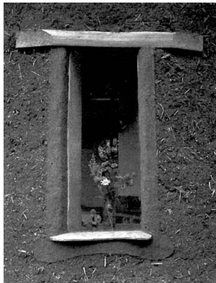
Эта оконная отделка из дитаймы продержалась 5 лет на очень открытой стене, 50% лошадиный навоз, 50% местная красная глина.
